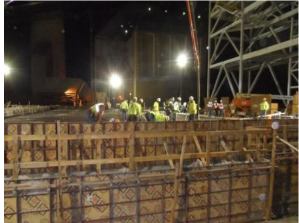
08-17-13 Baghouse-west top pour
