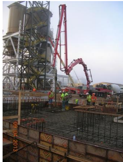
09-04-13 ID Fan 1B foundation – concrete
