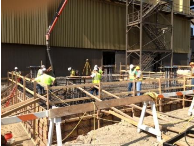
08-15-13 North SCR concrete pour
