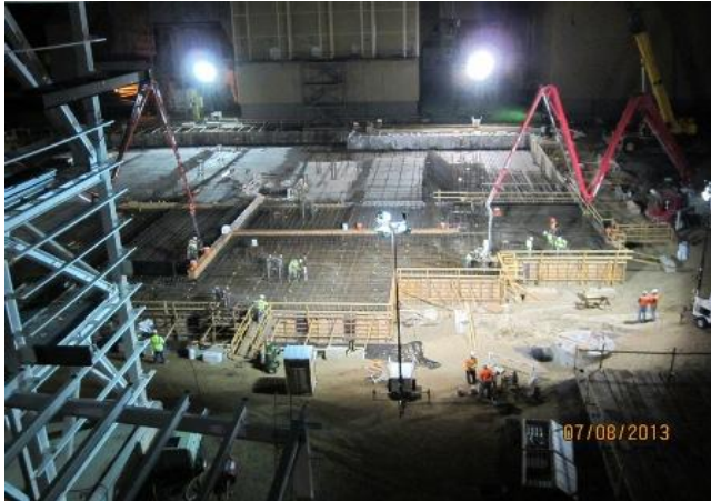
07-08-13 Baghouse & absorber bldg. 1 st concrete pour
