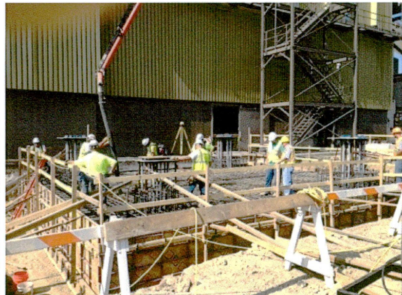
8-15 North SCR concrete pour
