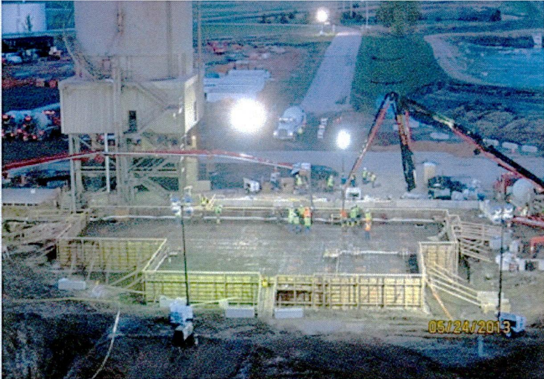
5-24 First major concrete pour
