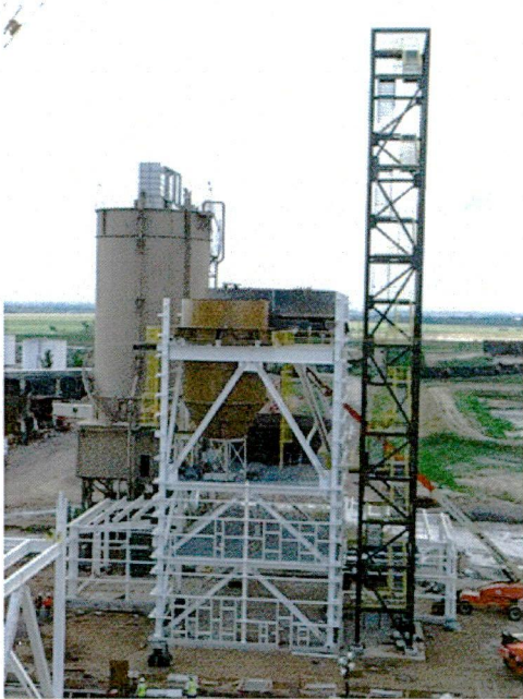
8-9 WA/PL silo erection
