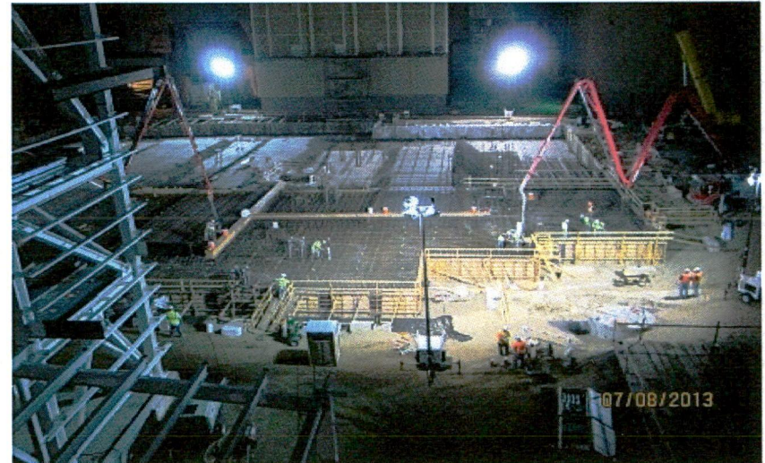
7-08 Baghouse/CFB bldg. concrete pour
