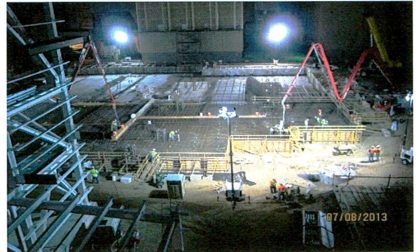
7-08 Baghouse/CFB bldg. concrete pour
