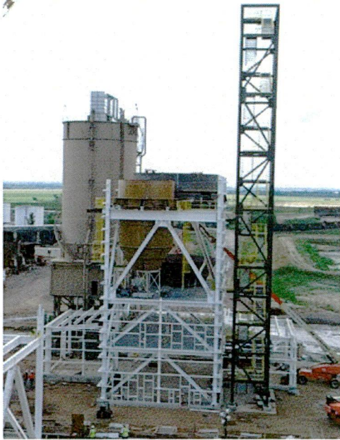
8-9 WA/PL silo erection
