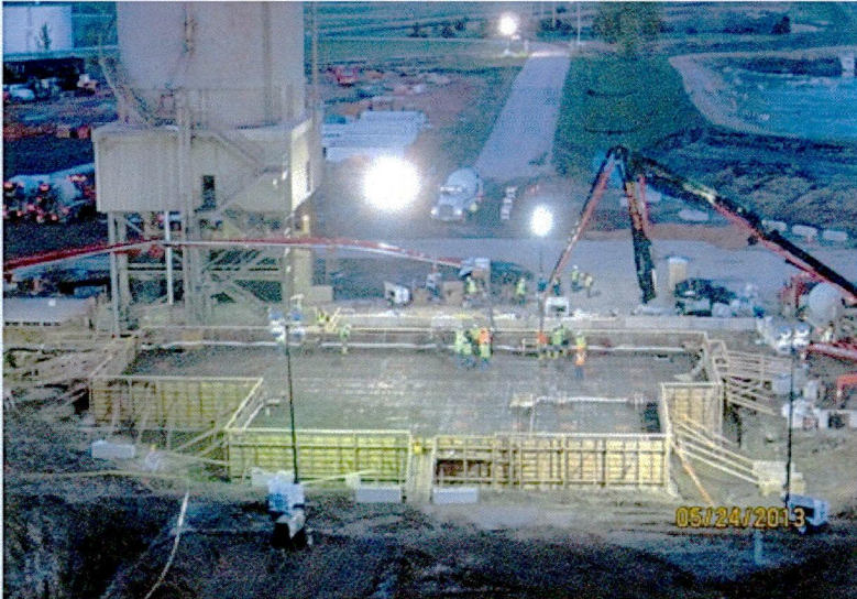
5-24 First major concrete pour
