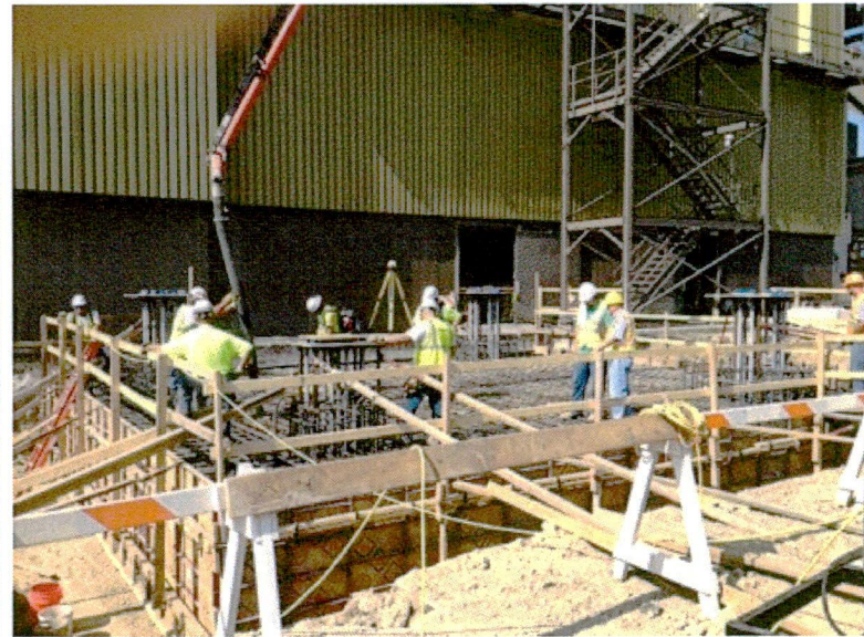
8-15 North SCR concrete pour
