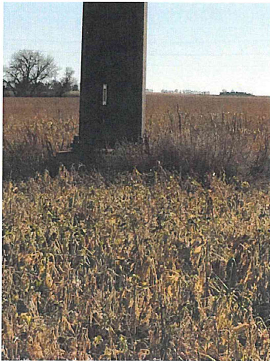
Poles 011 Base Looking S.
