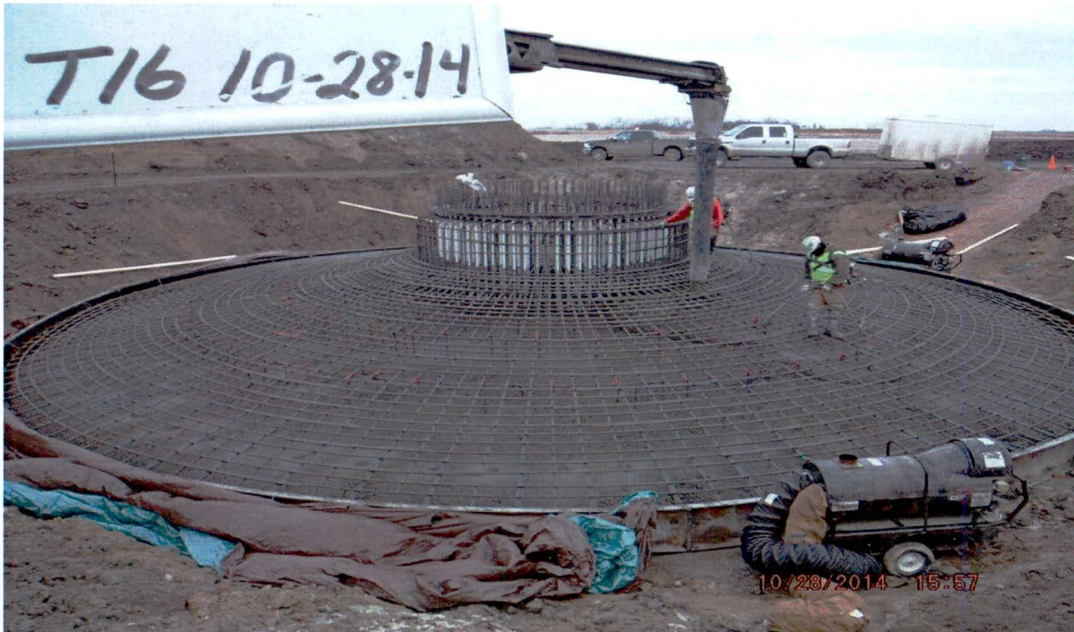
Border Winds - T16 Foundation Base Pour
