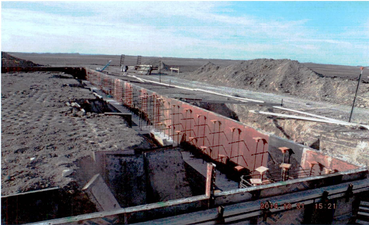
Border Winds – O&M Forming For Wall Pour
