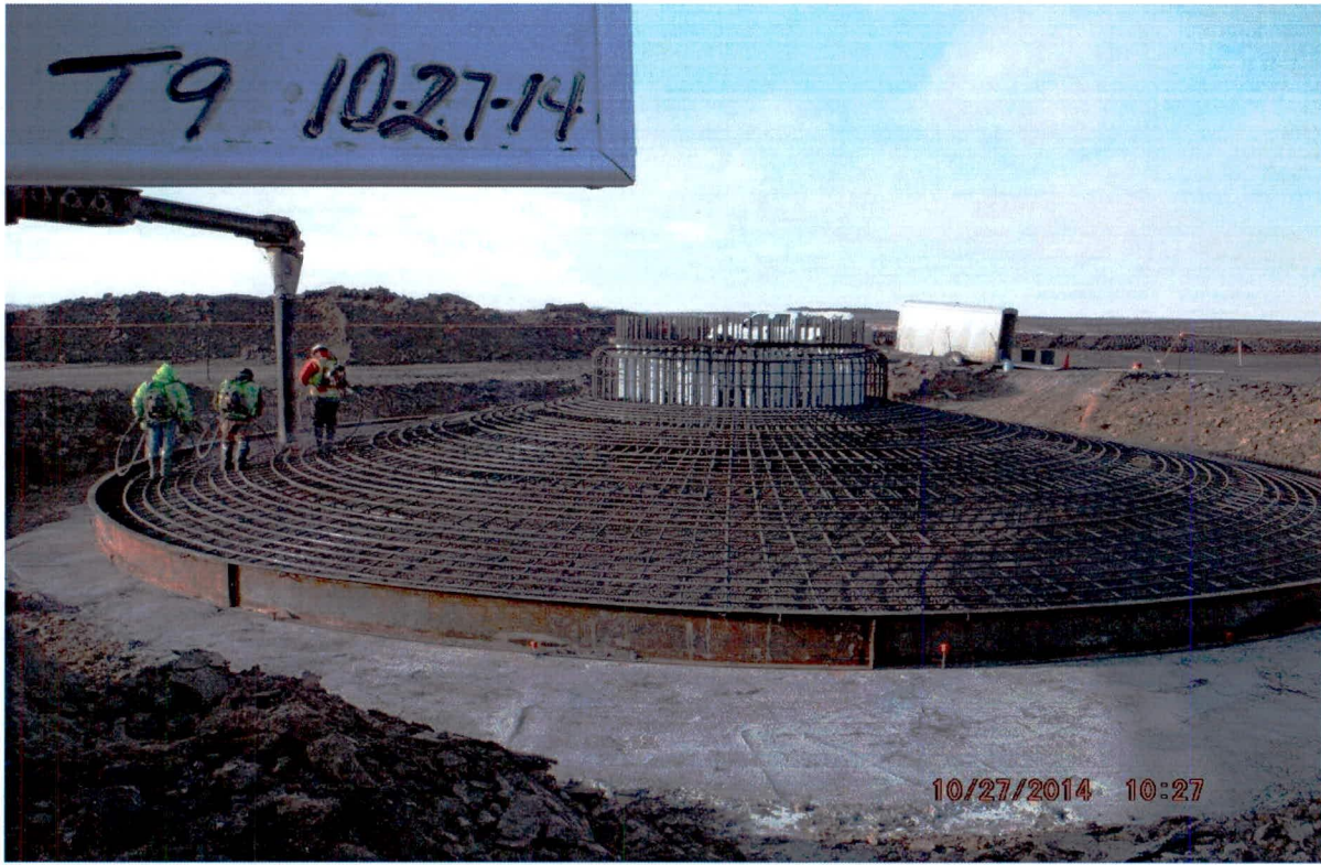
Border Winds - T9 Foundation Base Pour
