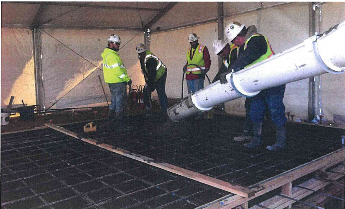
Concrete pour at Substation
