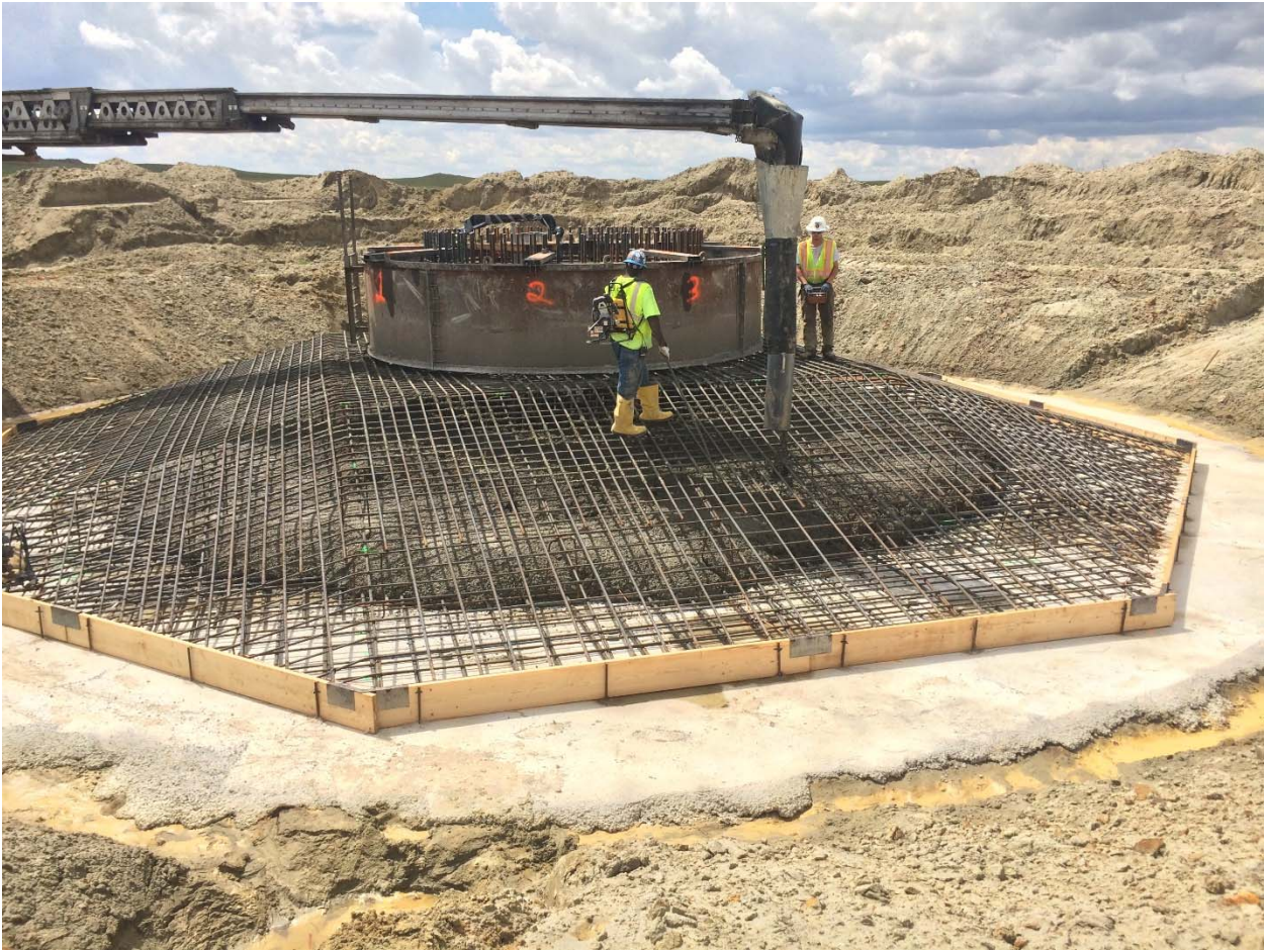
Foundation Pour at Turbine 8
