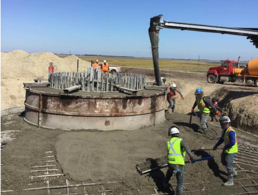
Foundation Concrete Pour
