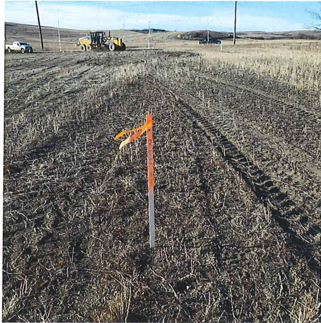
P6 - STA 14+00 AH, Existing Conditions
