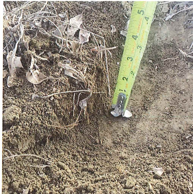
P31 - STA 54+40 Existing Topsoil
