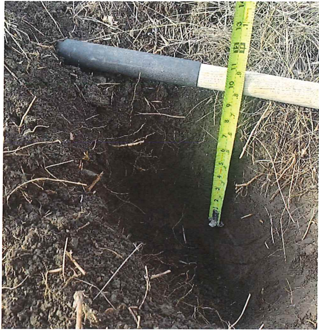
P25 - STA 7+22 Existing Topsoil
