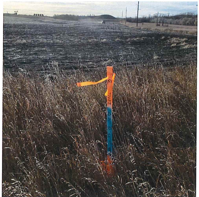
P12 - STA 37+82 AH, Existing Conditions
