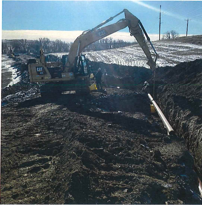
P19 – STA 21+73 AH_Pipe Installment
