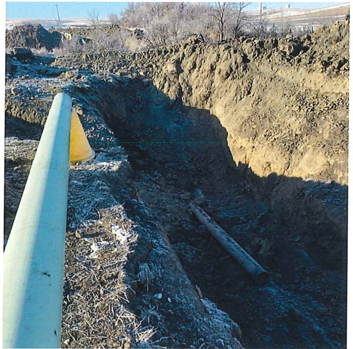
P9 - STA 10+80 Bore End
