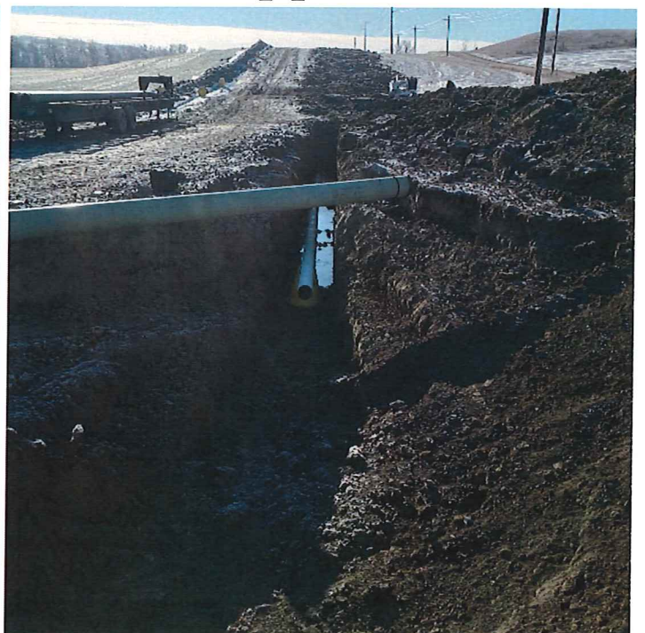
P15 – STA 15+42 AH_PI_Trench
