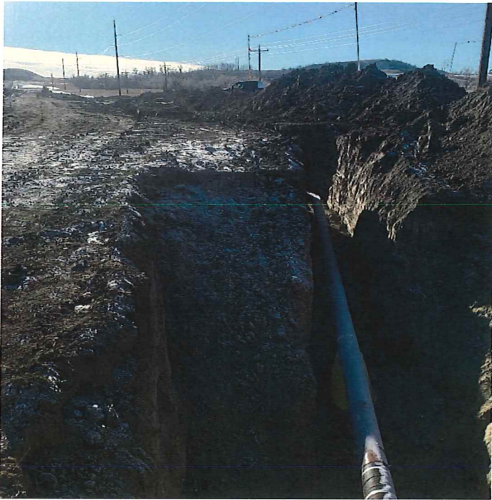
P29 – STA 37+82 AH
