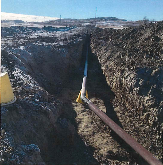
P27 – STA 32+07 AH_Pipe PI
