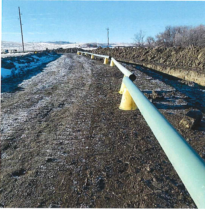
P12 – STA 12+40 AH_8 IN Pipe Staging
