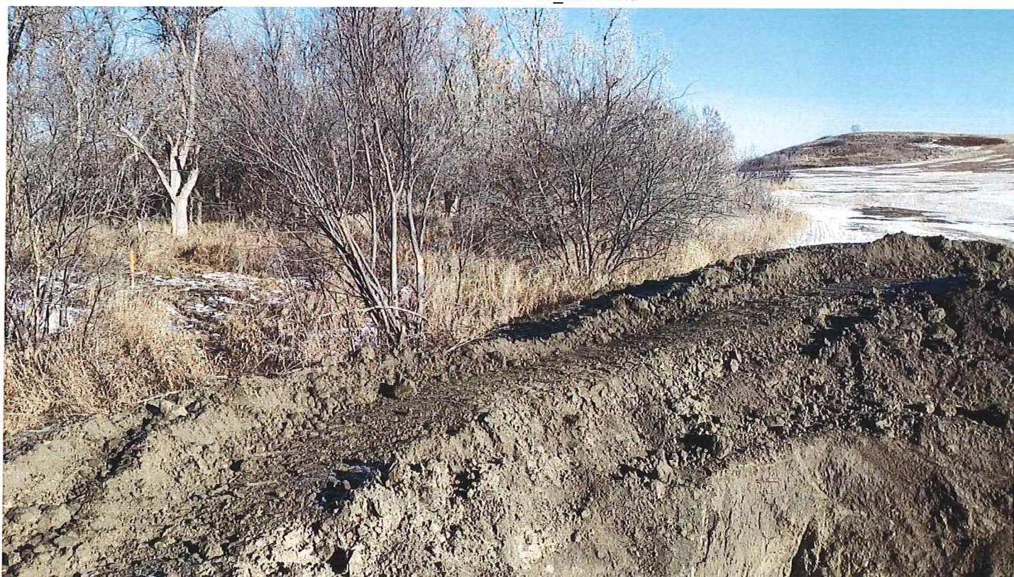
P25 – STA 30+09 LT_Bore End
