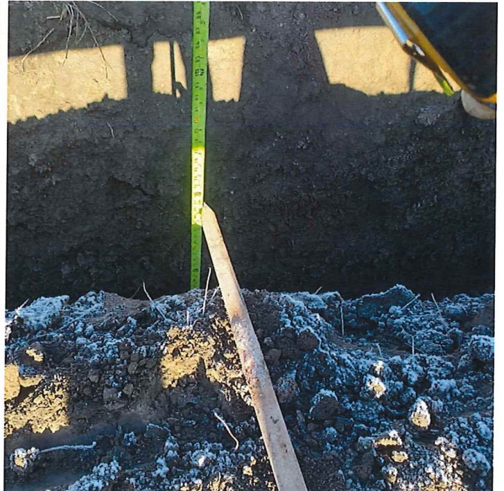
P7 – STA 10+00 Trench Depth
