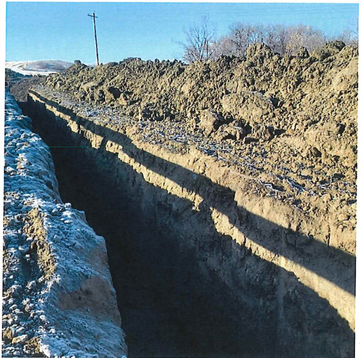
P13 – STA 13+40 AH_Trench
