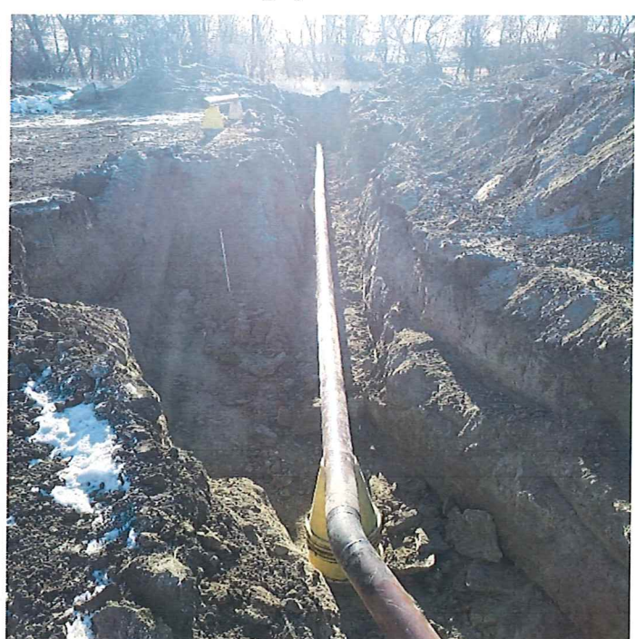
P22 – STA 26+37 AH_Pipe PI
