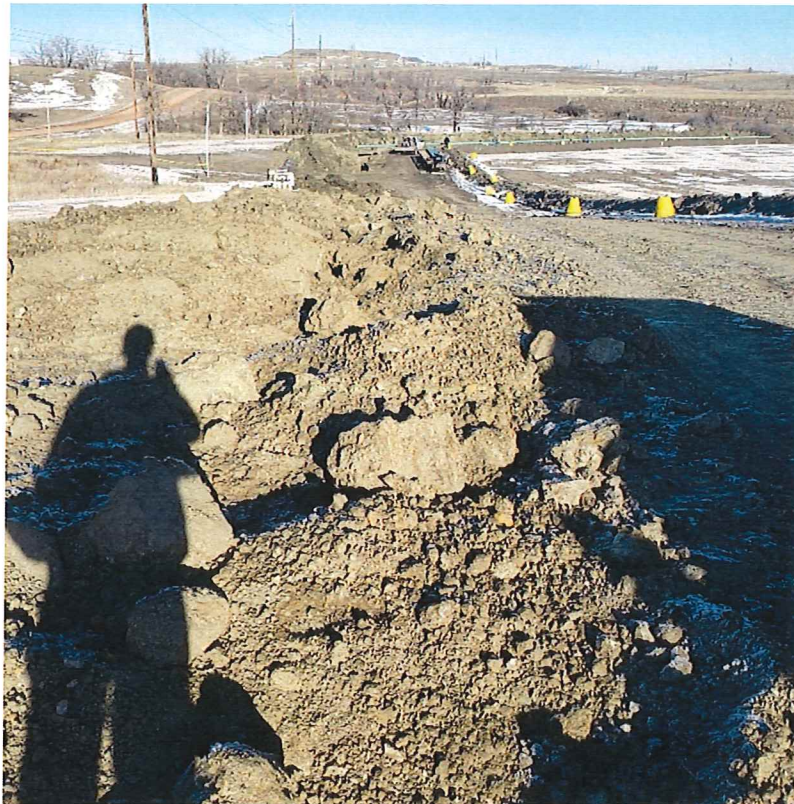
P18 – STA 19+00 BK_Trench Backfill
