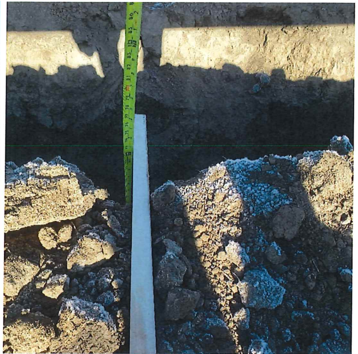
P5 - STA 8+00 Trench Depth
