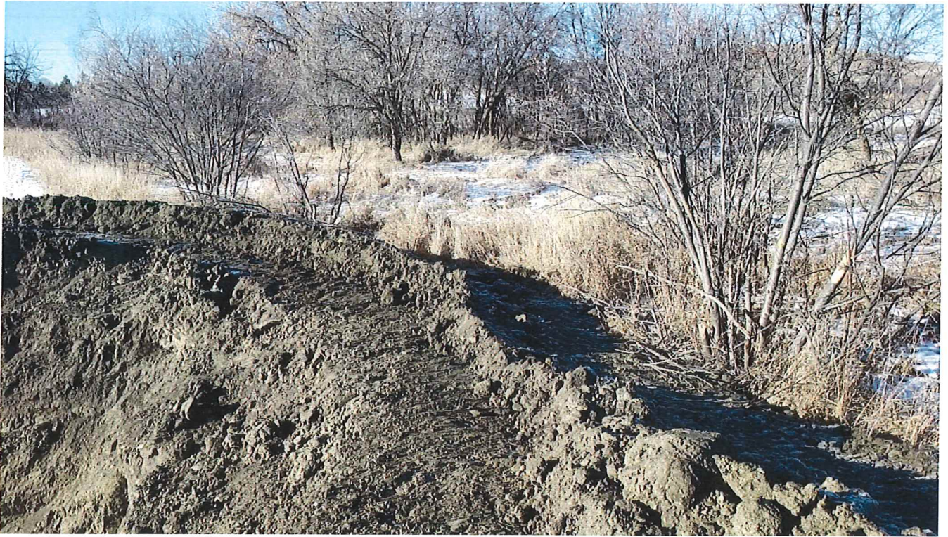
P26 – STA 30+09 RT_Bore End
