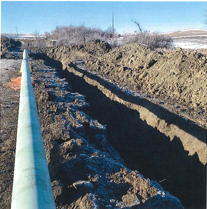
P6 – STA 10+00 AH_Trench
