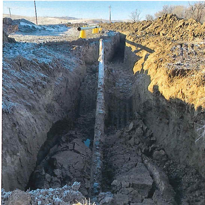
P10 – STA 12+20 AH_Bore End
