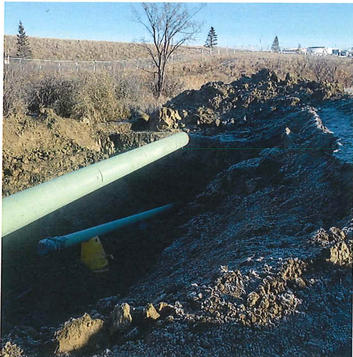
P1 – STA 7+26 BK_Bore End
