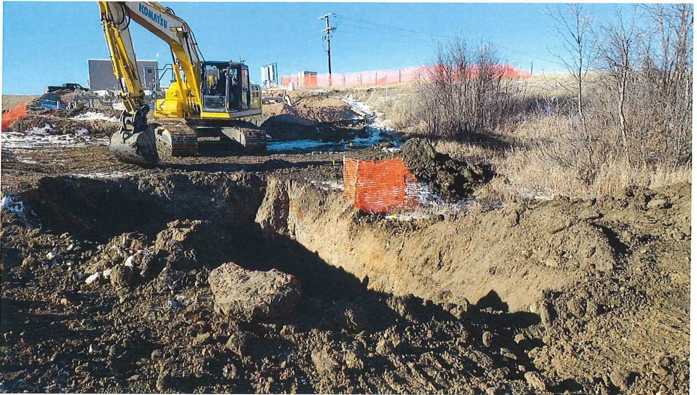
P39 – STA 67+25 AH_Bore End
