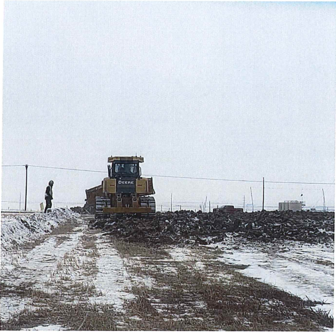
P29 – STA 6+50 BK, Longitudinal Topsoil Ripping
