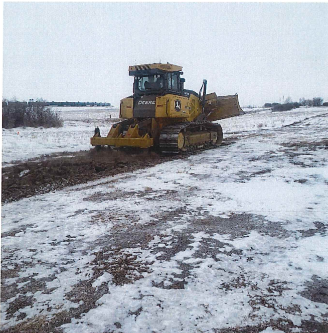
P27 – STA 6+00 AH LT, Longitudinal Topsoil Ripping
