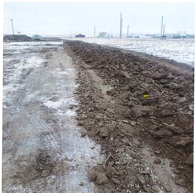
P28 – STA 6+00 BK LT, Longitudinal Topsoil Ripping
